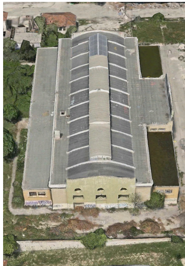
VUE NORD OUEST
