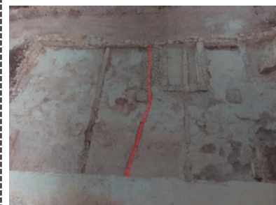
Canalisation en tuiles
