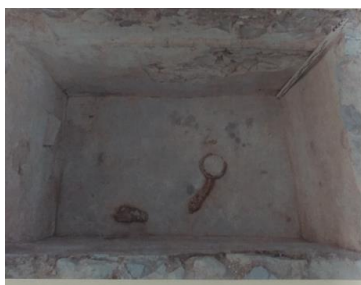
Bassin extérieur de récupération des eaux pluviales
