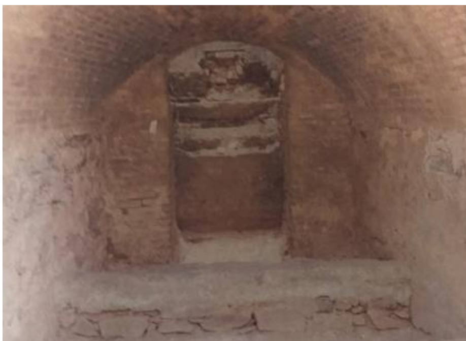
Fig 04: Porte de la chaudière occidentale. Source : Rapport d'Anne Marie d'Ovidio Page 61
