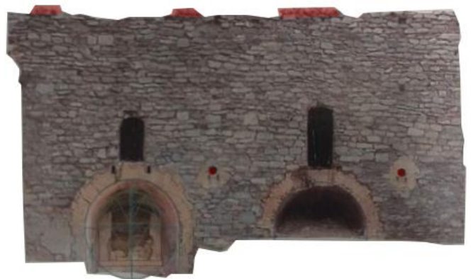
Fig 19: Façade du four à chaux. Voutes canonnières avec arc en plein cintre et arc en anse de panier. Sur orthophotographie, B.Sillano, Inrap.
