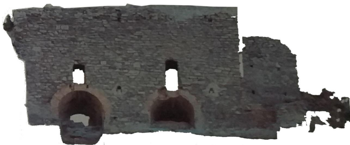
Fig 07: Nuage de point par la photogramétrie du four de la Panouse
