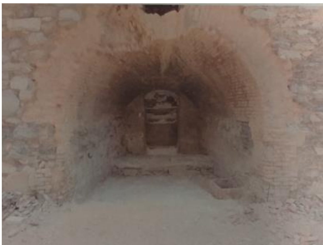
Fig 06: Gueule de défournement du four à chaux Source : Rapport d'Anne Marie d'Ovidio Page 62
