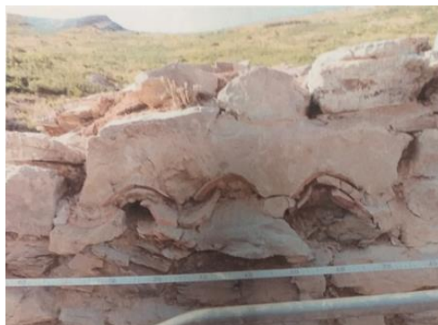
Fig 18: Encastrement tuiles dites rive de tête
