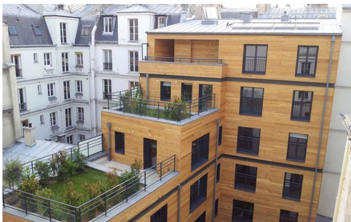
réhabilitation d'ancien bureau en cogénération
