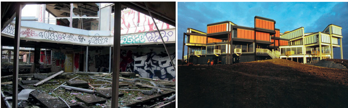
Fig 7. Ecole d'architecture de Nanterre - Label XXe - Jacques Kalisz Photo : Serge Kalisz - 2015 et DoCoMoMo France - 1971
