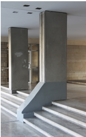
Fig 48. Renfort structurel Séquence d'entrée
