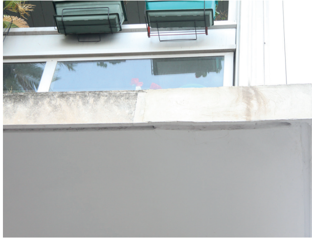
Fig 53. Réparation d'une pierre sur un nez de dalle Angle Prado
