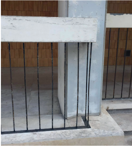
Fig 52. Intégration de l'ancien garde-corps Rue Daumier
