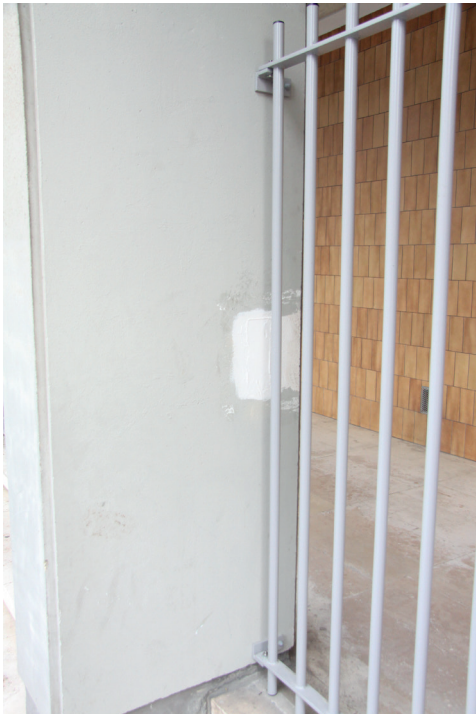
Fig 54. Intégration du nouveau garde-corps Rue Daumier
