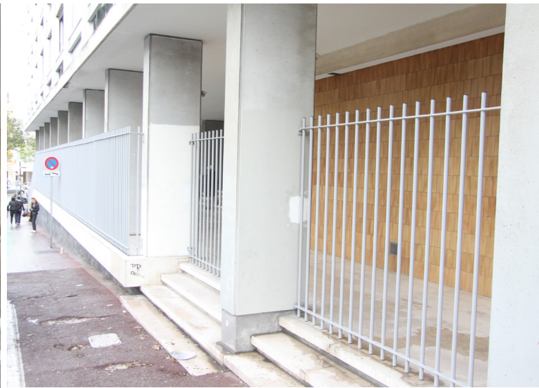
Fig 49. Remplacement du garde-corps pour un barreaudage Rue Daumier
