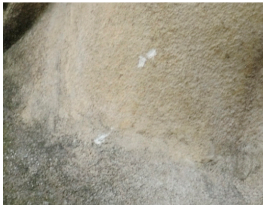
Photographies de décollements de la couche de protection au niveau des jambes de la statue
