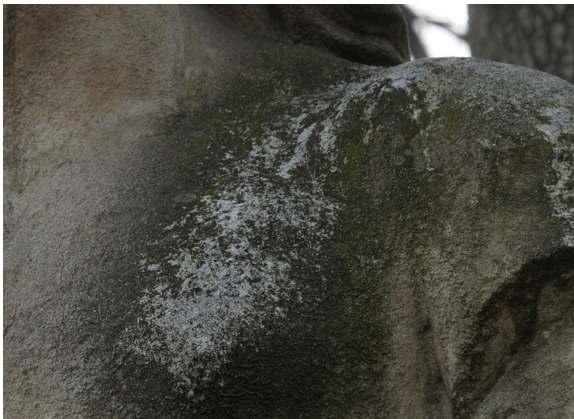
Photographies d'altérations chromatiques : blanchiment du torse de la statue (à gauche) et coloration grise du socle (à droite)
