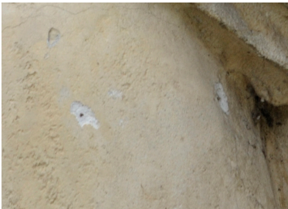
Photographies de décollements de la couche de protection au niveau des jambes de la statue
