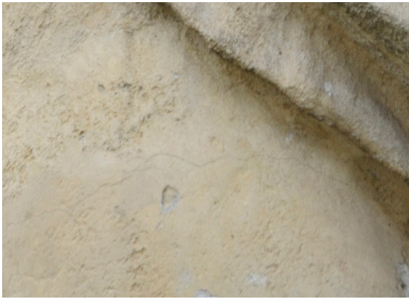
Photographie d'une fissure présente sur la jambe droite de la statue
