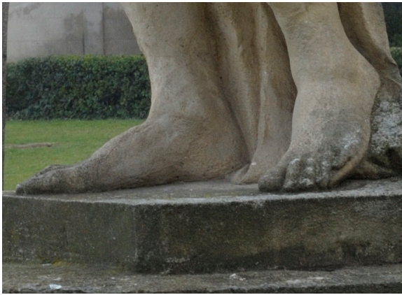
Photographies d'érosion sur la pierre de la statue, au niveau des pieds (à gauche) et du modelé de la jambe (à droite)
