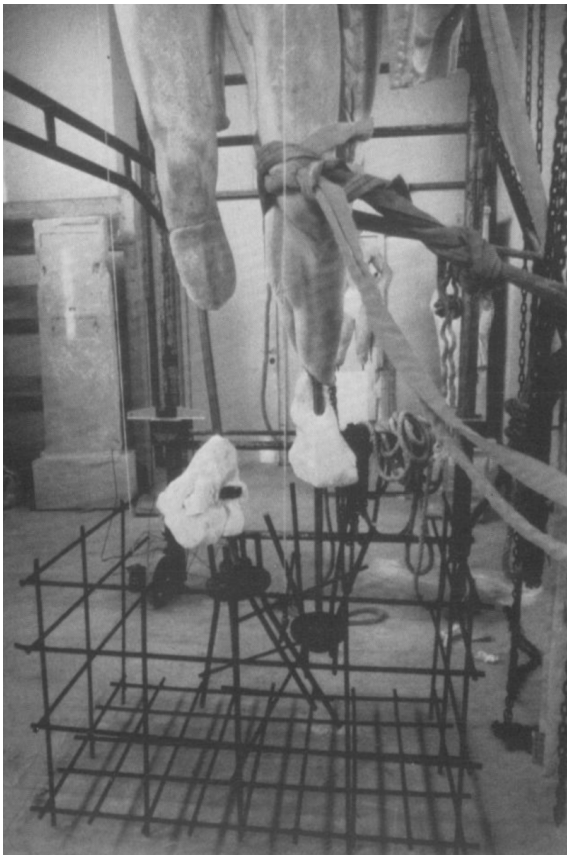
Photographies du ferailage du socle et du montage de la statue
