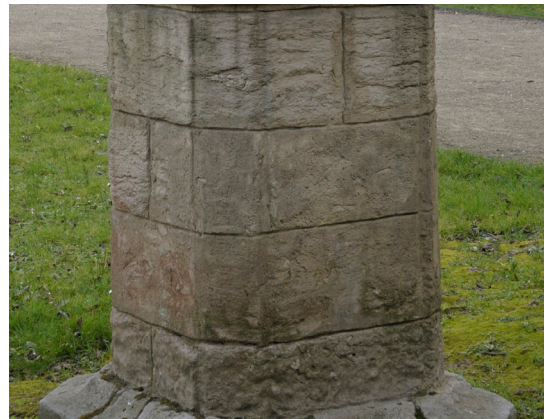
Photographies d'altérations chromatiques : blanchiment du torse de la statue (à gauche) et coloration grise du socle (à droite)
